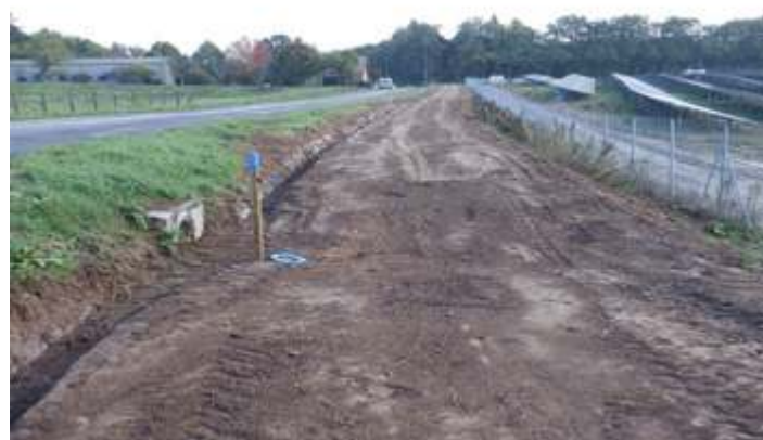
Chantier à St Pardoux l'Ortigier déplacement de la conduite d'eau suite à la création d'un champ solaire (Panneaux Photovoltaïques).
