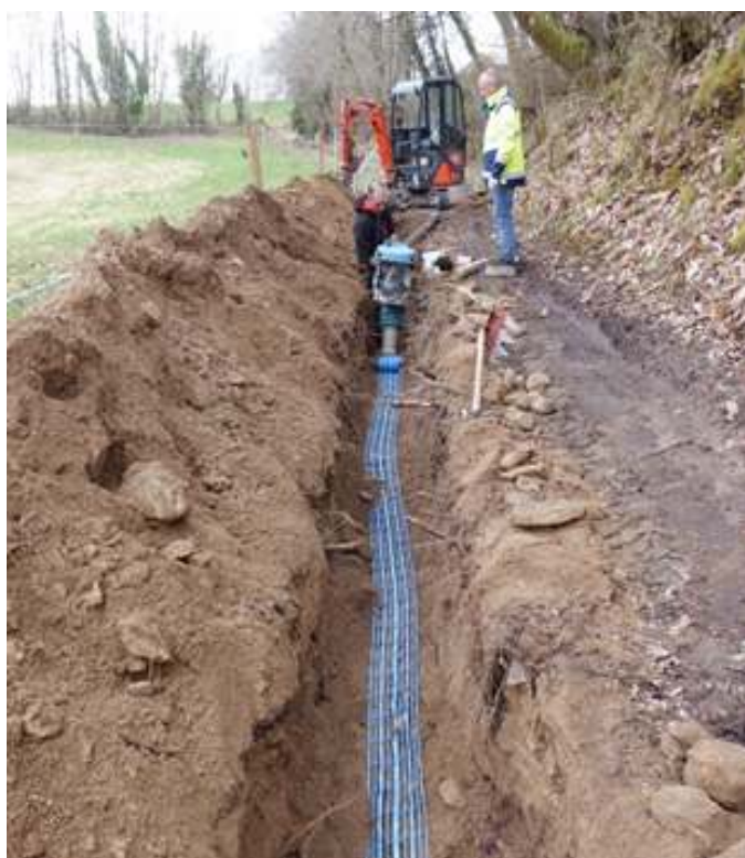
Chantier à Estivaux (Cessac Bas).
