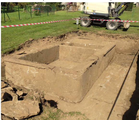
Exhaussement des lavoirs enfouis
